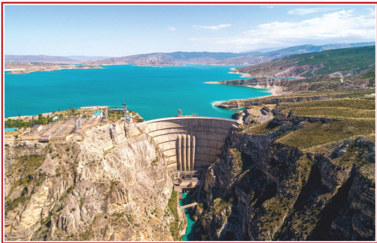
Чиркейская ГЭС на реке Сулак в Республике Дагестан. Крупнейшая ГЭС на Северном Кавказе. Место съемки: Республика Дагестан, Чиркейская ГЭС. Автор: Станислав Степанов.
