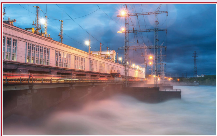
Камская ГЭС. Ведется холостой сброс воды во время пропуска весеннего паводка. Место съемки: г. Пермь. Автор: Константин Каменский.
