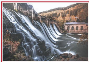
ГЭС «Пороги». Старейшая гидроэлектростанция России с уникальной историей, редким оборудованием. Станция проработала почти 100 лет, остановившись только в 2017 году. Место съемки: Челябинская область д. Пороги Саткинского района. Автор: Даниил Силантьев.
